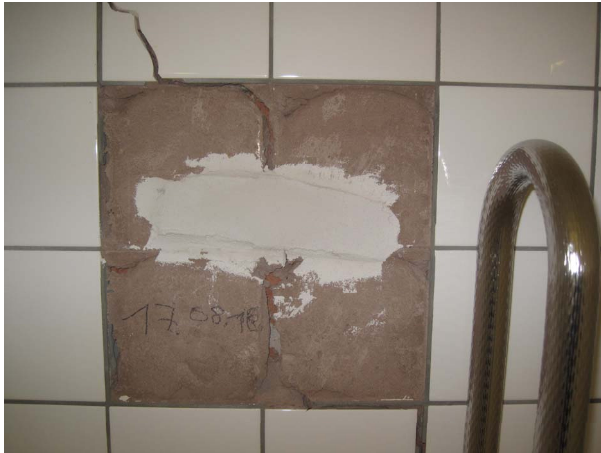
Zementmörtelbett mit Wandfliesen
