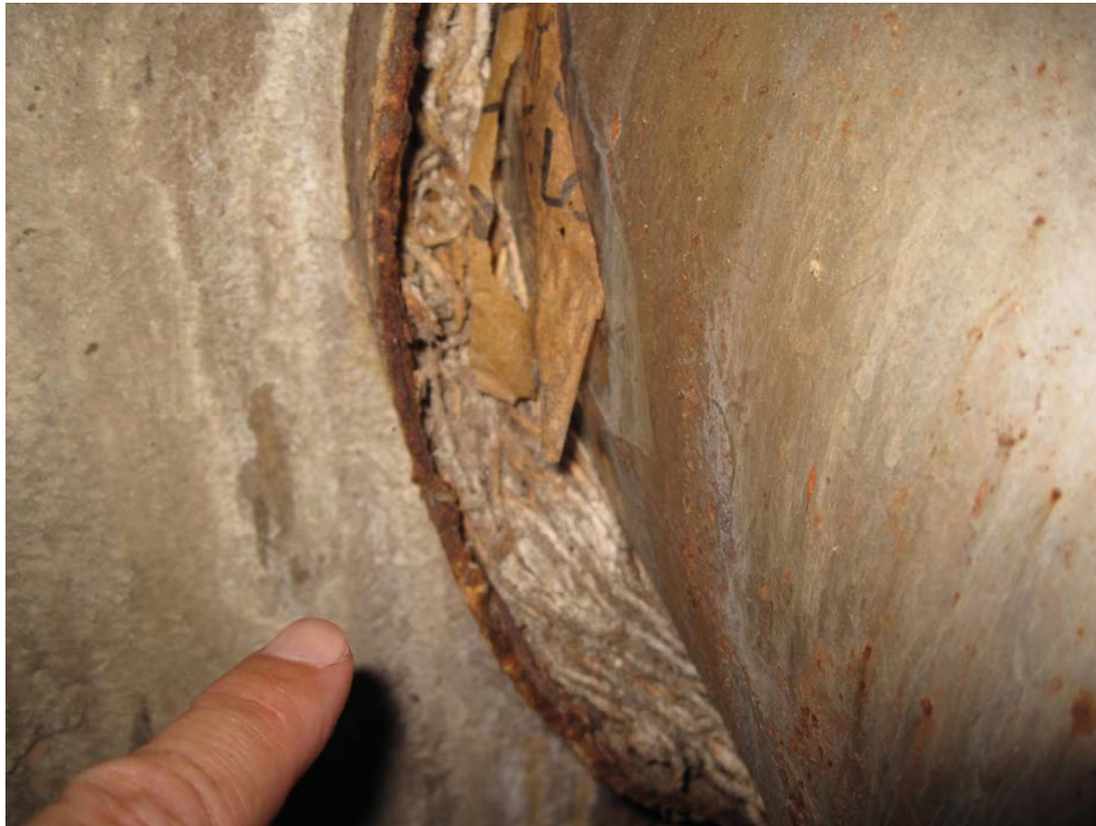
Asbestdichtschnüre im Ofen-/Heizungsbau (PK Gandersheim)
