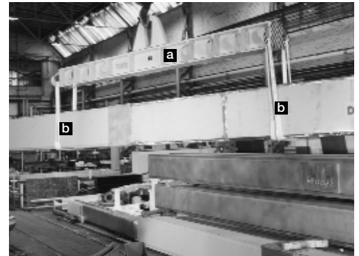
Bild 1: Einsatz des richtigen Anschlagmittels. Der Spreizbalken (a) verhindert, dass die Gurten (b) zusammenrutschen.
