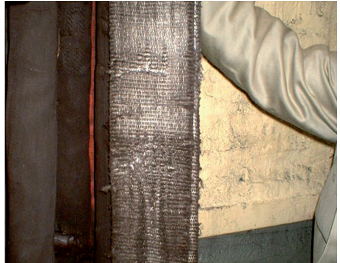
Bild 3-2: Prüfung durch einen Sachkundigen, Beispiel 2
