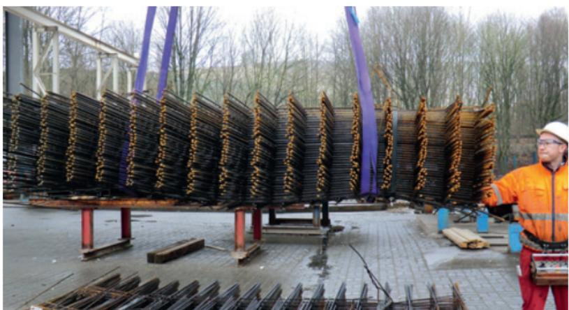
Fachgerechtes Anschlagen und der Einsatz geeigneter Anschlagmittel sind die Voraussetzung für den sicheren Transport von Lasten.
