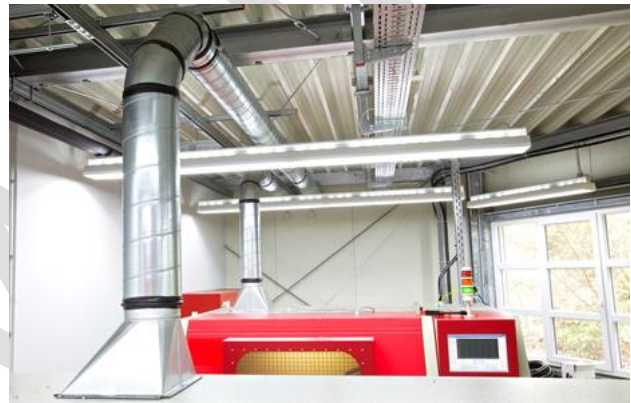
Bild 12: Absaugung an Prüfständen
