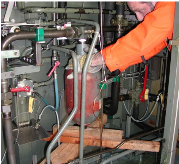
Abb. 1 Instandhalter bei Wartungsarbeiten
