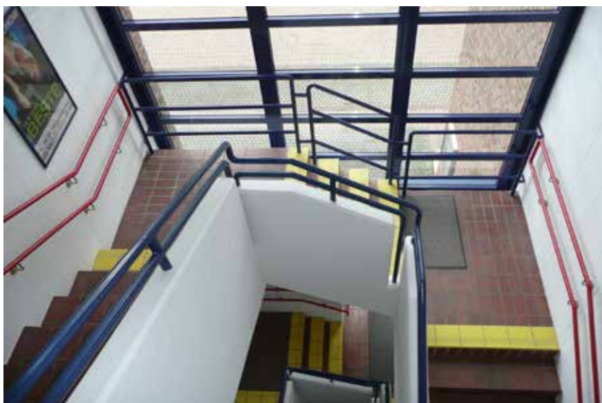
Abb. 16: Treppe mit auffälliger Stufenkennzeichnung und beidseitigem Handlauf
