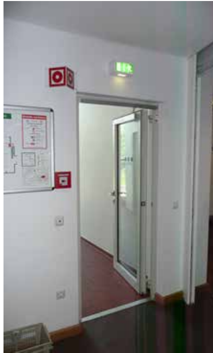
Abb. 9: Gekennzeichneter Fluchtweg ins Treppenhaus
