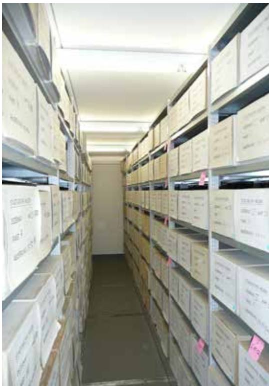
Abb. 21: Fahrregalanlage mit Beleuchtung
