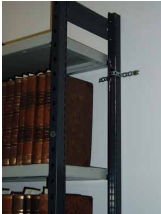
Abb. 24.: Regal mit Wandbefestigung
