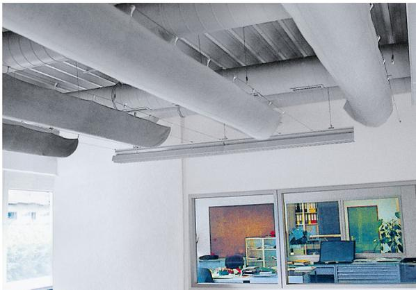
Zugfreie Belüftung durch Gewebeschläuche
