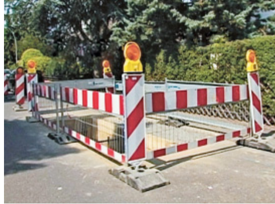
Absicherung einer Grube
