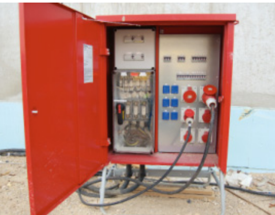
Baustromverteilerschrank
