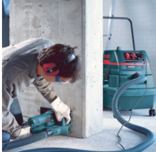
Mauernutfräse mit Staubabsaugung
