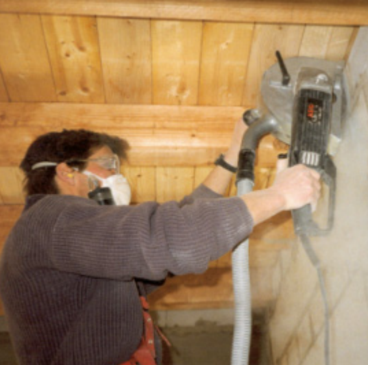
Staubentwicklung beim Mauernutfräsen trotz eingeschalteter Absaugung bedingt den Einsatz von Atemschutz
