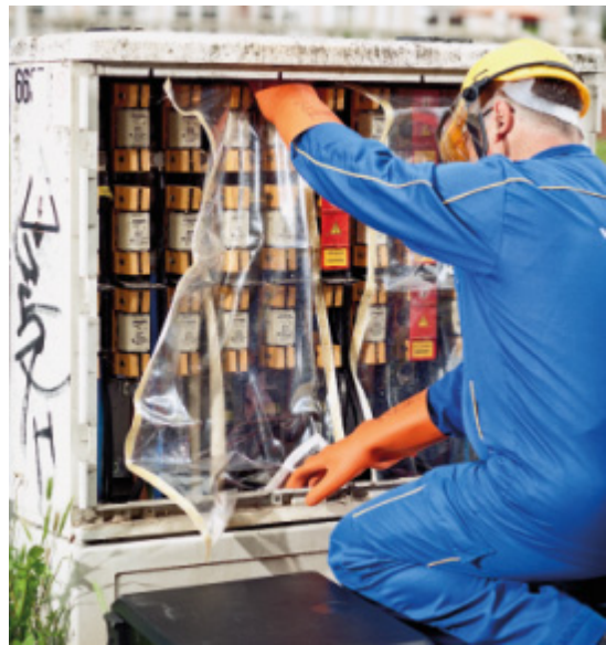
Abdecken benachbarter, unter Spannung stehender Teile
