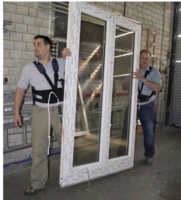
Abb. 3.4.5-04 Transport mit Hilfe von Tragegurten
