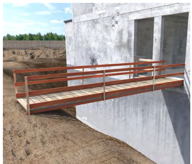
Abb. 3.5.2-03 Laufsteg mit Seitenschutz als Verkehrsweg
